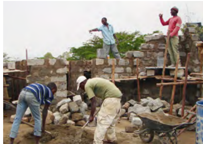
Mbagathi Steiner Schule, Nairobi: Bau des neuen Kindergartengebäudes
